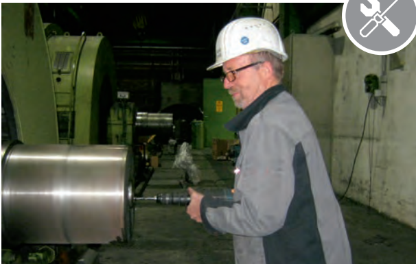
Vorbereitung der Montage / Preparation of Installation
