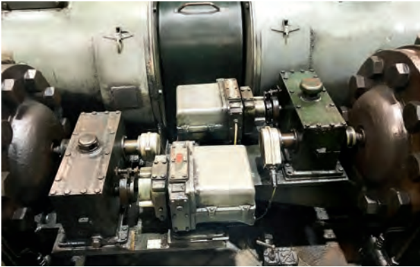
Vorher: Mechanische Kopierwerke / Before: Mechanical cam limit switches
