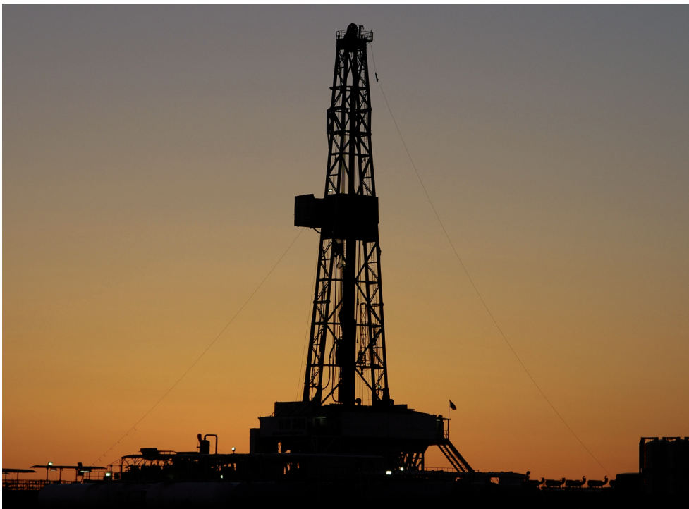
Ölbohrtürme (auch Tieftemperatur-Anwendungen)
